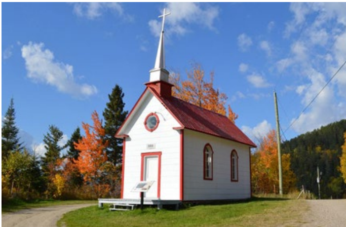
La chapelle du Tableau a été construite par Basile Villeneuve (père) vers 1911 pour desservir la petite communauté installée dans le secteur depuis le milieu du 19 e siècle. Le style de la chapelle est représentatif du courant néoclassique. 130, chemin du Tableau, Sainte-Rose-du-Nord.
