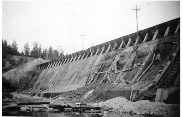
Barrage de la chute aux Galets au moment de sa construction, en 1929. Source : Facebook. « Anciens et actuels de St-David-de-Falardeau » [en ligne]
