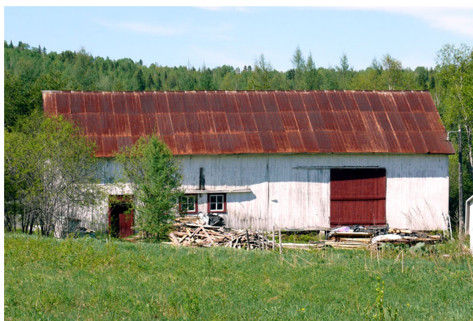
Grange-étable derrière le 1509, route de Tadoussac.
