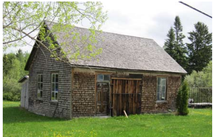
Ancienne école de rang transformée en bâtiment agricole, mais dans un état d'authenticité remarquable. 636, 2 e Rang, Saint-Charles-de-Bourget.
