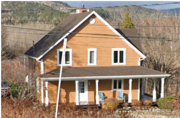
Maison vernaculaire américaine d'un étage et demi avec pignon en façade. 3, rue du Couvent, L'Anse-Saint-Jean.
