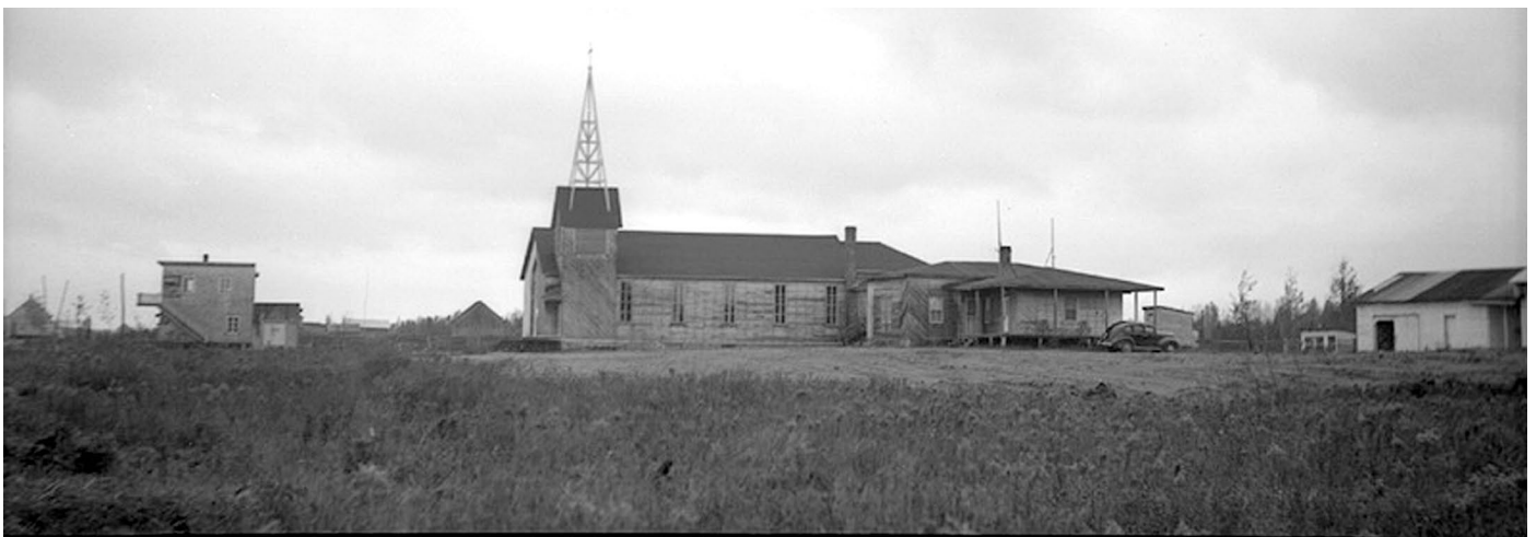
Vue de profil de la première église Saint-David, du presbytère attenant, ainsi que des dépendances, en 1941. Source : © BANQ, cote E6,S7,SS1,P3801
