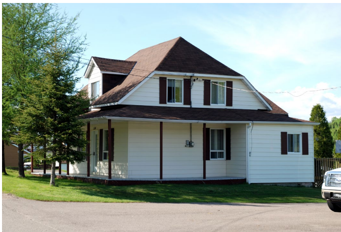
Maison située au 114, rue du Moulin.
