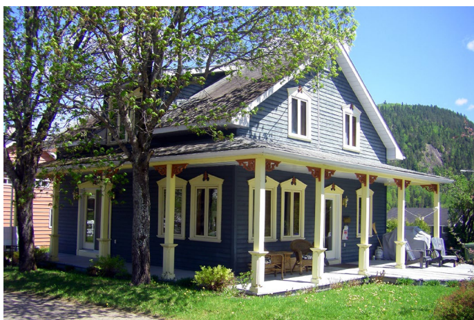
Maison située au 16, rue Tremblay.
