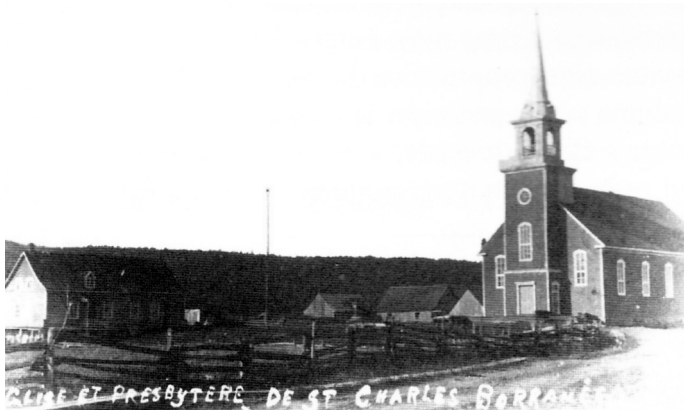
Une première église Saint-Charles-Borromée est construite en 1899-1900 dans le secteur de la Grande Décharge, à peu de distance de la chute à Caron. Source : Russel BOUCHARD. « Saint-Charles-de-Bourget : Petite histoire d'un grand dérangement ». Saguenayensia . 2011, vol. 52, n° 3, p. 17.
