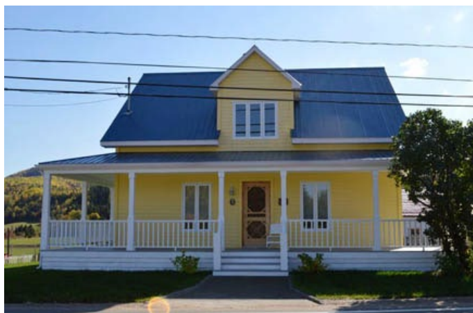
Maison vernaculaire américaine avec lucarne centrale. La lucarne à pignon, de grande dimension, est en continuité avec le mur de façade (pendante). 9, rue des Coteaux, L'Anse-Saint-Jean.
