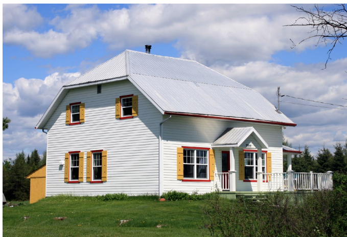
Maison vernaculaire américaine à toiture à demi-croupes, située au 3300, chemin du Cap.
