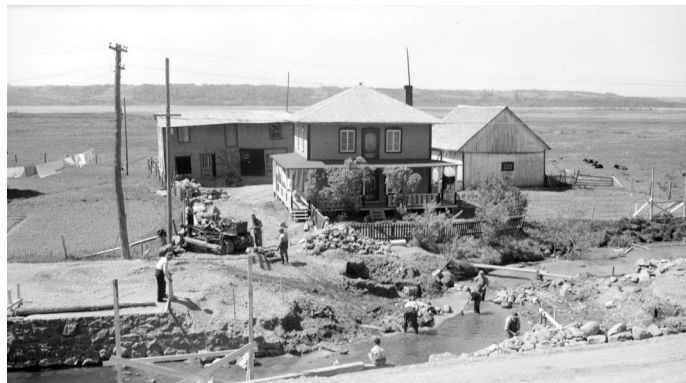
Construction des fondations du pont au-dessus de la rivière aux Foins, à Saint-Fulgence, avant le coulage de la structure en béton, en 1948. Une résidence de même que les battures et la rivière Saguenay sont visibles en arrière-plan. Source : J-Augustin FOURNIER. © BAnQ Québec, cote E6,S7,SS1,P65166
