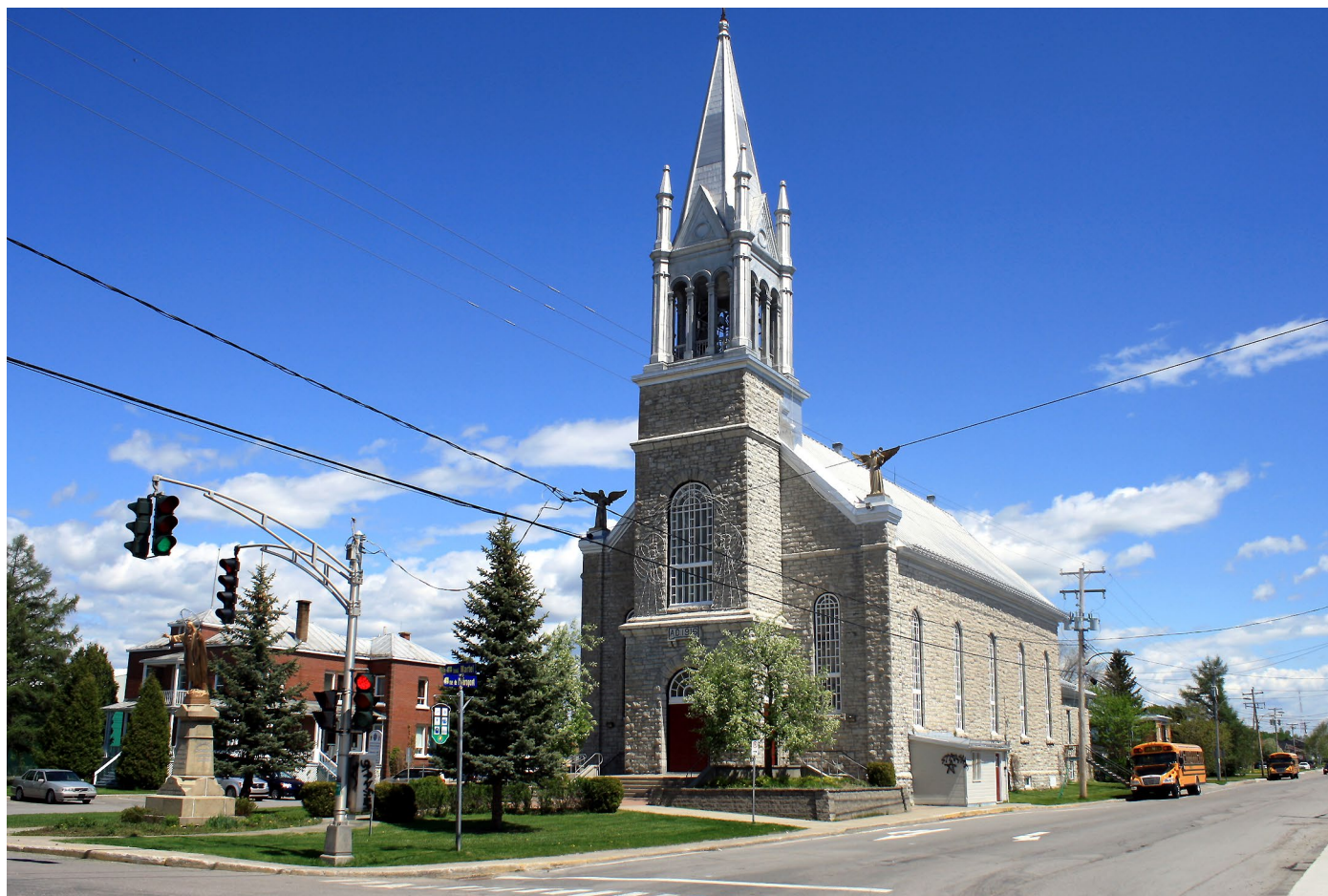
Construite en 1916, l'église Saint-Honoré est ornée au niveau de la façade principale de deux anges à la trompette, œuvres du sculpteur Louis Jobin.
