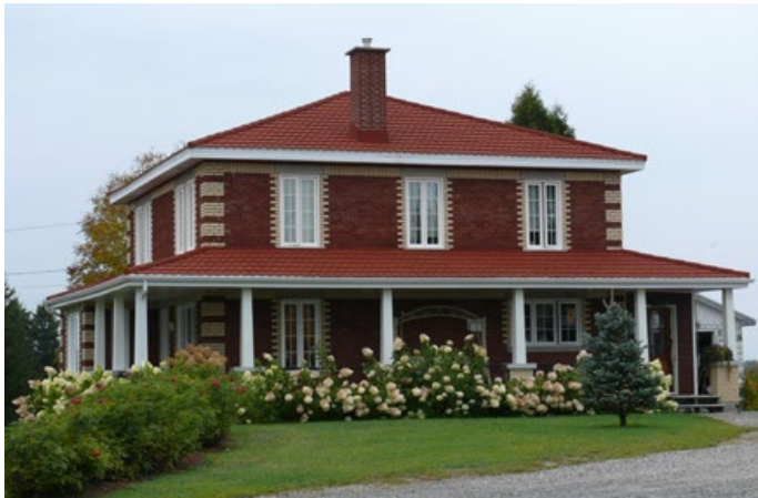
Maison cubique en brique dotée d'un toit à quatre versants et d'une galerie s'étendant sur plusieurs côtés. 1130, rue de l'Hôtel-de-Ville, Saint-Honoré.
