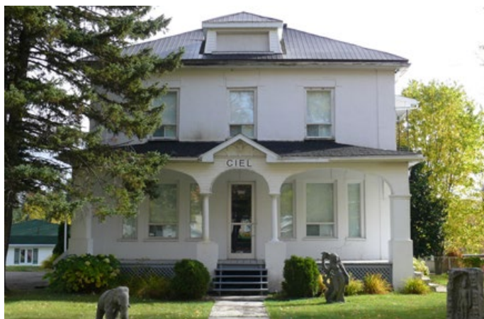
Ancien presbytère de la paroisse Saint-Gérard-Majella, bâti en 1924, bien avant l'église actuelle datant de 1960. 660, rue Gauthier, Larouche.
