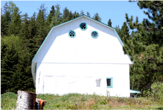
Grange-étable située au 396, route 381.
