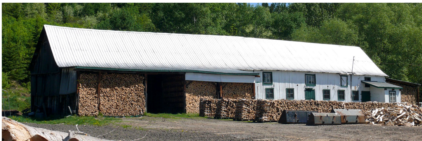
Grange située au 111, rue du Saguenay.
