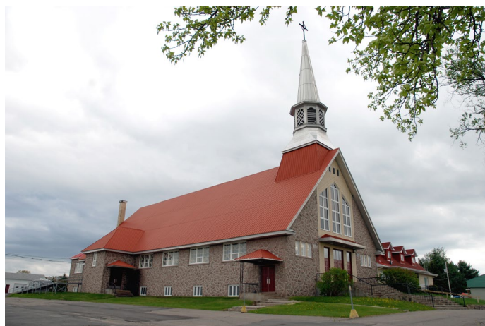
Deuxième église Saint-Jean-l'Évangéliste, construite en 1961-1962.
