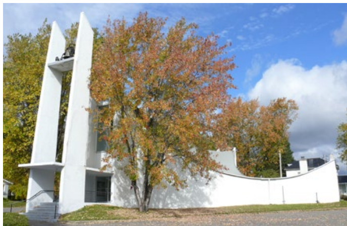
L'église de Saint-Gérard-Majella est une œuvre exceptionnelle des architectes St-Gelais Tremblay. Elle se démarque par son architecture moderne franche et avant-gardiste qui rompt avec la tradition. 656, rue Gauthier, Larouche.
