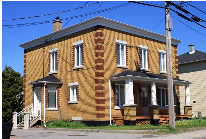
Maison cubique en brique, située au 358, rue Simard.
