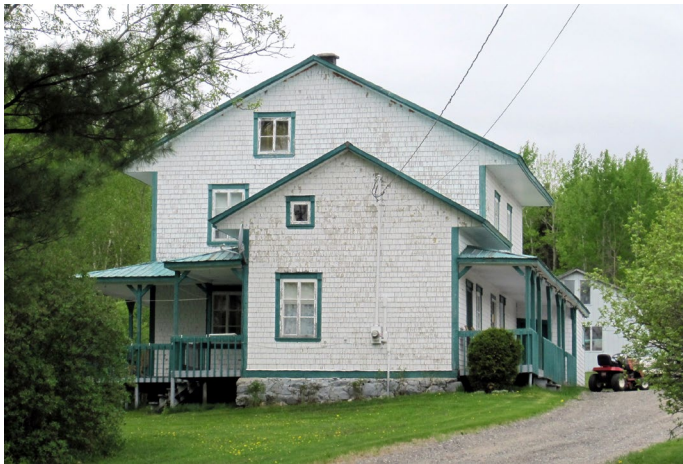
Maison ayant conservé son parement de bardeaux de bois, située au 564, 1 er Rang.
