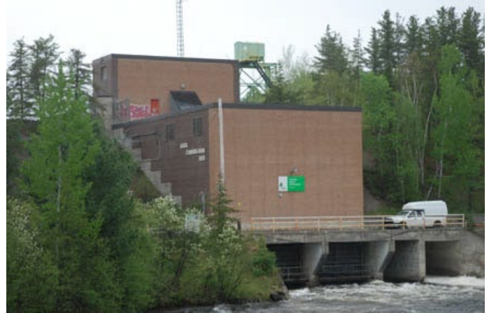
Centrale hydroélectrique Adam-Cunningham construite en 1953. Saint-David-de-Falardeau.
