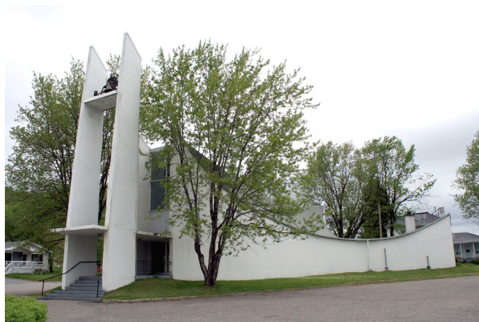
Église Saint-Gérard-Majella construite en 1960 selon les plans des architectes Evans Saint-Gelais et Fernand Tremblay.
