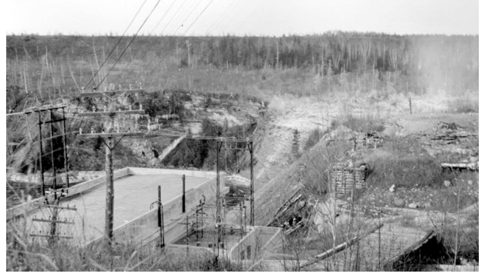
Travaux de construction du barrage de la chute aux Galets, sur la rivière Shipshaw, en 1929. Source : © BAnQ, cote E57,S44,SS1,PB19-74
