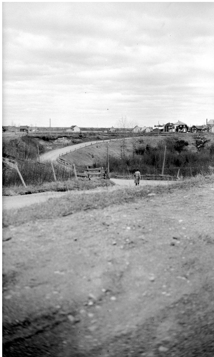
Vue à l'approche du village de Saint-Ambroise, en 1948. Un pont en bois est aménagé au-dessus de la rivière des Aulnaies, sur l'actuelle rue du Pont Ouest. Source : Jean COURNOYER, 1948. © BAnQ Québec, cote E6,S7,SS1,P62645
