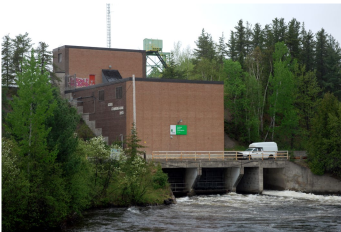
Centrale Adam-Cunningham construite en 1953.
