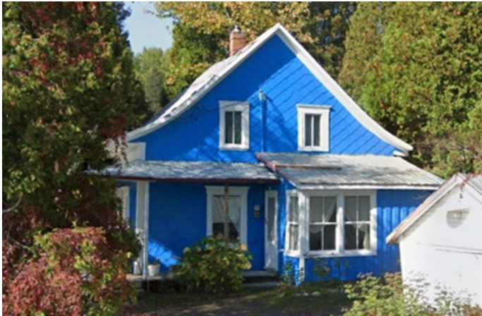
Maison québécoise d'influence néoclassique revêtue de bardeau d'amiantement alvéolés. 363, rue du Saguenay, Saint-Fulgence.
