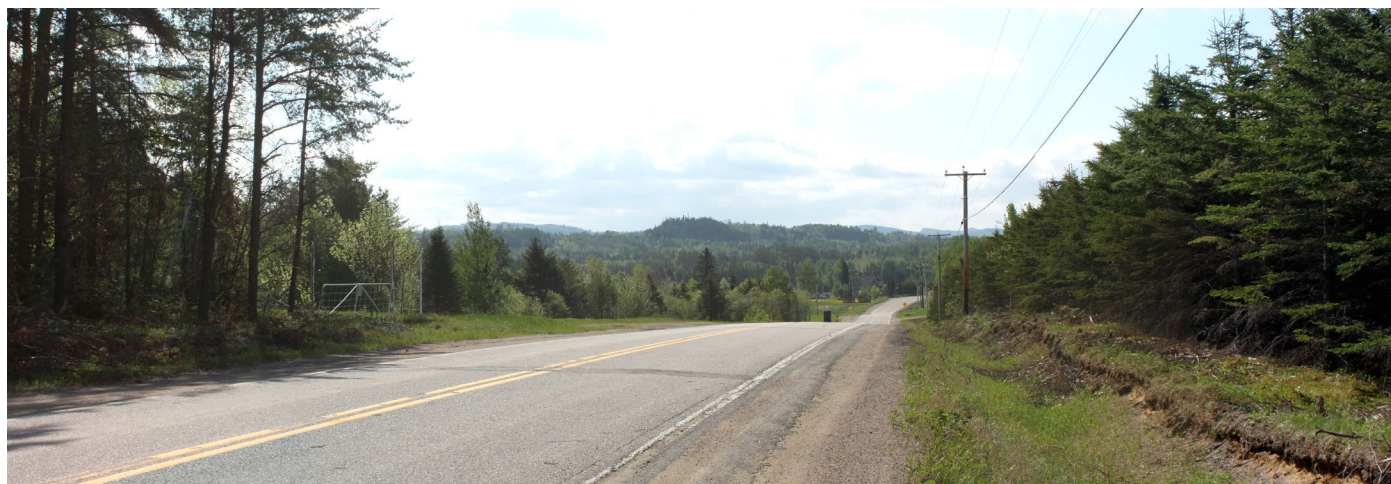
Vue cadrée de la route 381 en direction de la localité de Boilleau, à la hauteur du kilomètre 82.
