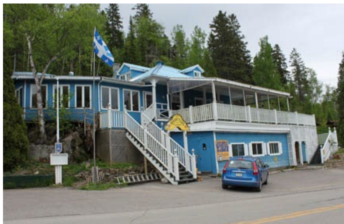
Immeuble commercial au cœur du village touristique de Sainte-Rose-du-Nord. 136, rue du Quai, Sainte-Rose-du-Nord
