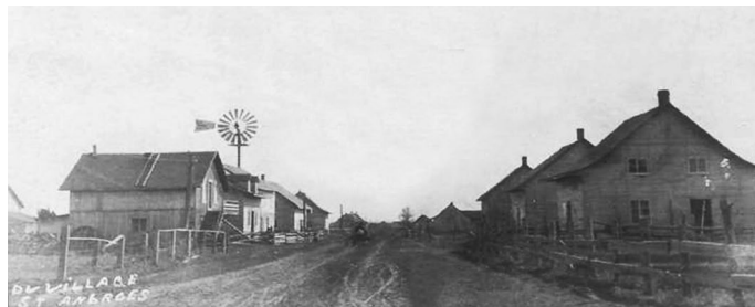
La rue Simard au début du 20 e siècle. Source : © Municipalité de Saint-Ambroise
