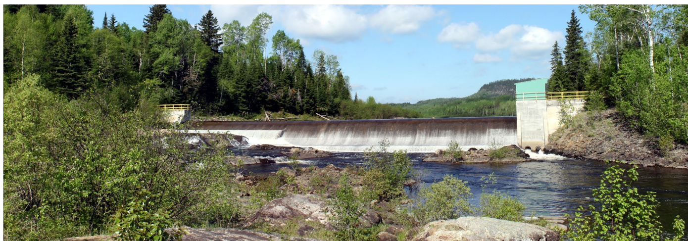
Vue sur le barrage déversoir du Lac-Ha ! Ha ! à partir de la halte routière du Pont-Couvert, dans le secteur de Boilleau.
