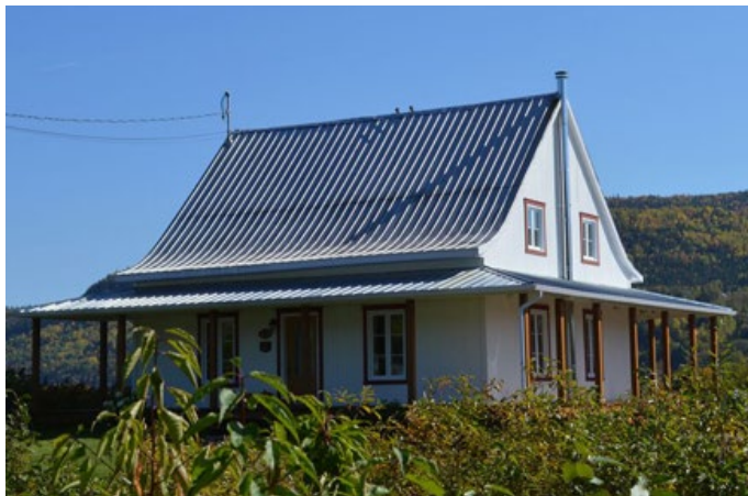
Maison québécoise d'influence néoclassique reconnaissable à son toit à deux versants à base recourbée recouverte de tôle, sa galerie et ses ouvertures disposées de façon symétrique. 6, chemin de l'Anse, L'Anse-Saint-Jean.
