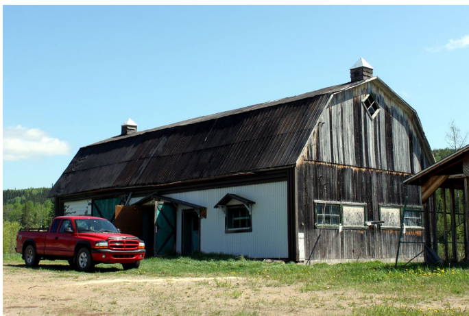
Grange-étable située au 1309, route 381
