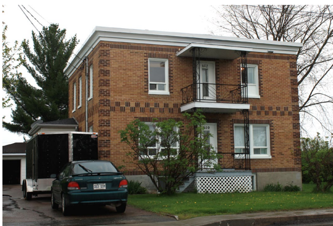
Grande maison en brique située au 610-612, rue de l'Aéroport.
