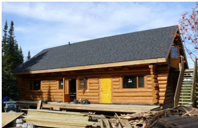
Chalet Antoine-Dubuc entièrement construit en bois rond. TNO Mont-Valin.
