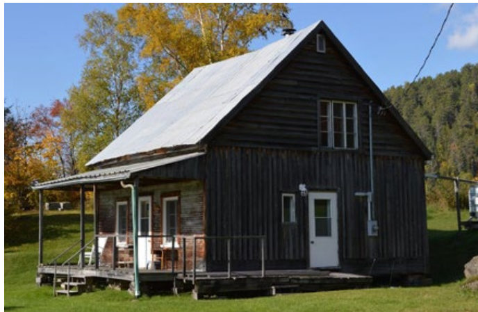
Maison vernaculaire américaine d'un étage et demi de facture modeste qui rappelle les premières maisons de colonisation. 131, chemin du Tableau, Sainte-Rose-du-Nord.
