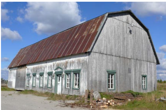
Grange-étable à toit brisé revêtu de planches de bois verticales. 103, 2 e Rang, Saint-David-de-Falardeau.
