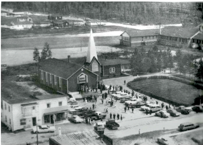
Vue aérienne du noyau paroissial de Saint-David, avec l'église, le presbytère attenant et l'école (en arrière-plan), vers 1960. Source : Facebook. « Anciens et actuels de St-David-de-Falardeau » [en ligne]
