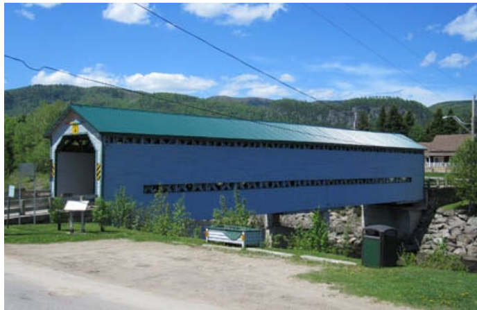
Le pont du Faubourg est le dernier représentant des quatre ponts couverts qui reliaient autrefois les deux rives de la rivière Saint-Jean et l'un des trois derniers représentants des ponts couverts toujours existants dans la région du Saguenay-Lac-Saint-Jean. Laurent Bouchard, célèbre charpentier-menuisier de L'Anse-Saint-Jean, a participé à la construction de 14 ponts couverts de type Town québécois, dont celui en 1921.
