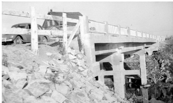
Le pont de la rivière à l'Ours après le remplacement de l'assemblage en bois pour une structure en béton. Source : C. MILOT, 1948. © BAnQ Québec, cote E6,S7,SS1,P37554
