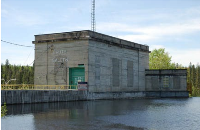
Prise d'eau de la centrale hydroélectrique de la Chute-aux-Galets aménagée en 1921. Saint-David-de-Falardeau.
