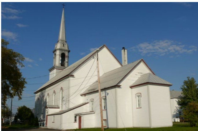
L'église de Saint-Charles-Borromée, construite en 1915-1916 d'après les plans de l'architecte Joseph-Pierre Ouellet, possède une architecture traditionnelle. Elle est située dans un site patrimonial cité. 364, rue Principale, Saint-Charles-de-Bourget.
