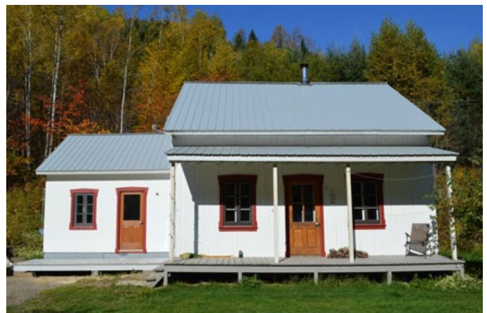
Maison vernaculaire américaine d'un étage et demi typique avec son toit à deux versants droits sans lucarnes et sa galerie couverte d'un auvent indépendant. 456, chemin Périgny, L'Anse-Saint-Jean.
