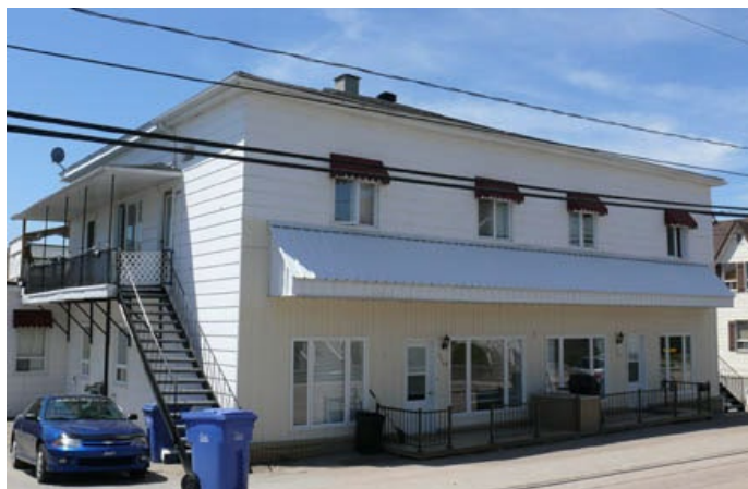
Bâtiment typique des villages québécois à vocation mixte comportant des locaux commerciaux au rez-de-chaussée et des logements à l'étage. 244-246, rue du Saguenay, Saint-Fulgence
