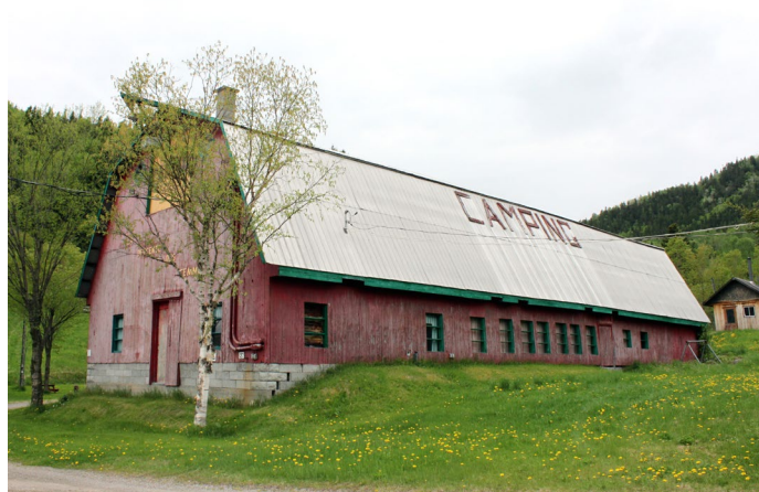
Ancienne grange de la rue de la Montagne, convertie en bloc sanitaire et aire de repas pour un camping.
