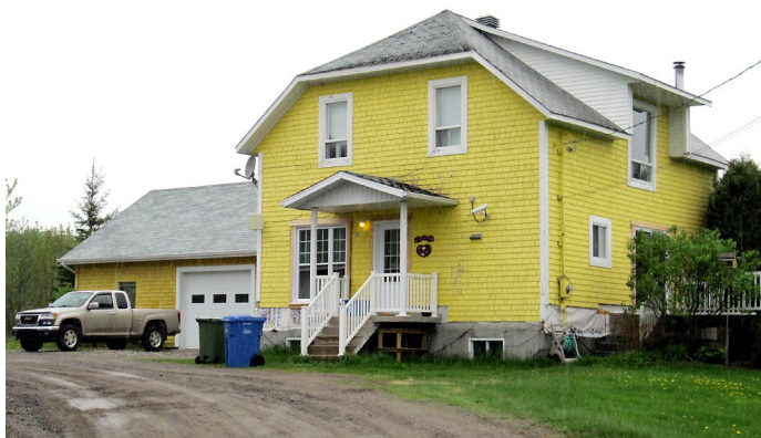
Maison ayant conservé son parement traditionnel en bardeau de bois.
