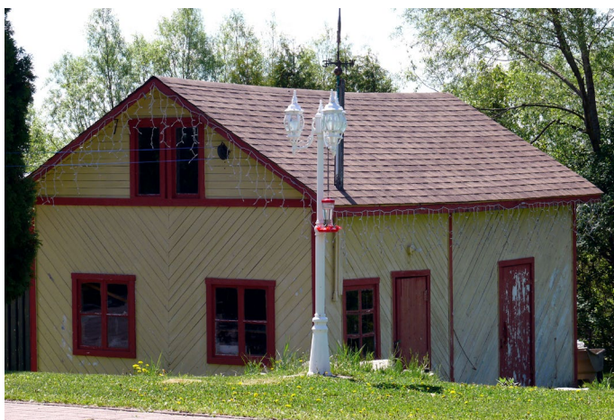
Bâtiment secondaire situé derrière le 162, rue du Saguenay.
