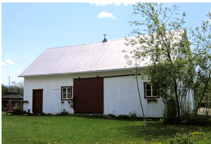
Bâtiment agricole situé dans le rang Saint-Thomas Nord.
