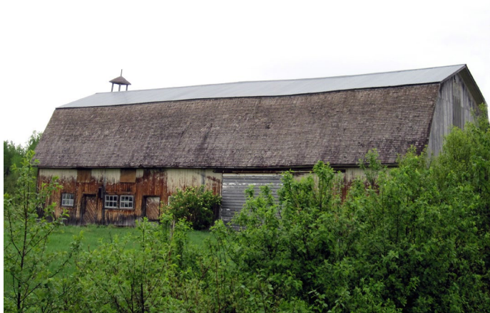
Grange-étable à toit brisé visible sur le 9 e Rang.
