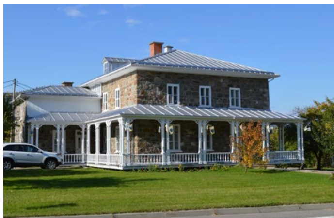
Le presbytère de la paroisse de Saint-Jean-Baptiste (1892) forme un bel ensemble avec l'église en pierre construite à la même époque. 261, rue Saint-Jean-Baptiste, L'Anse-Saint-Jean.
