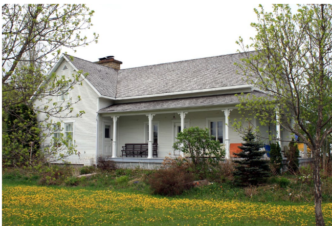
Maison située au 936, route des Fondateurs.
