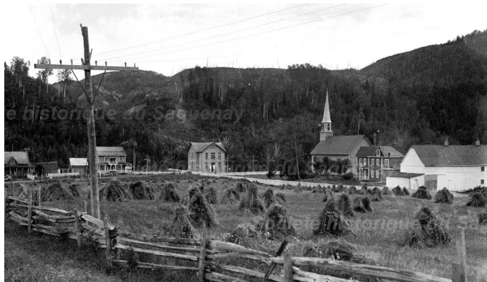
Vue à l'approche du noyau villageois de Petit-Saguenay, vers 1935. La première église Saint-François-d'Assise est visible en arrière-plan à la droite de l'image, tandis que l'ancienne salle communautaire s'élève au centre de la prise de vue. Source : © Société historique du Saguenay, cote SHS-P002-S7-SS1-P11062-3
