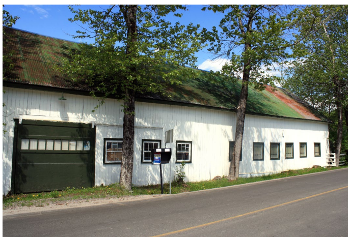
Grange-étable située au 4000, chemin du Cap.
