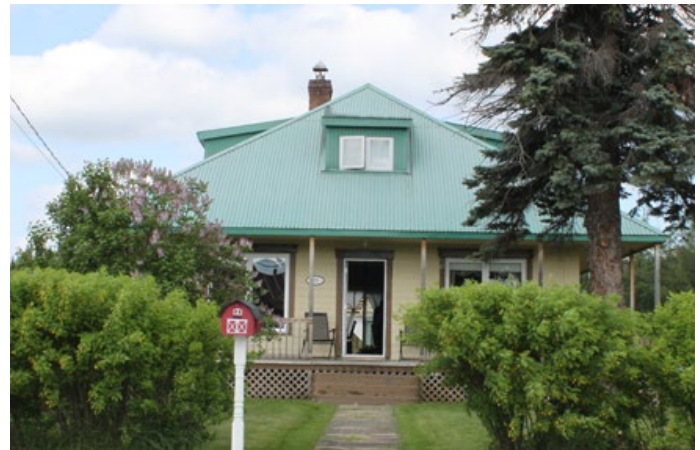
Maison vernaculaire américaine à toit à quatre versants dotée de lucarnes en appentis. 458, route 381, Ferland-et-Boilleau.
