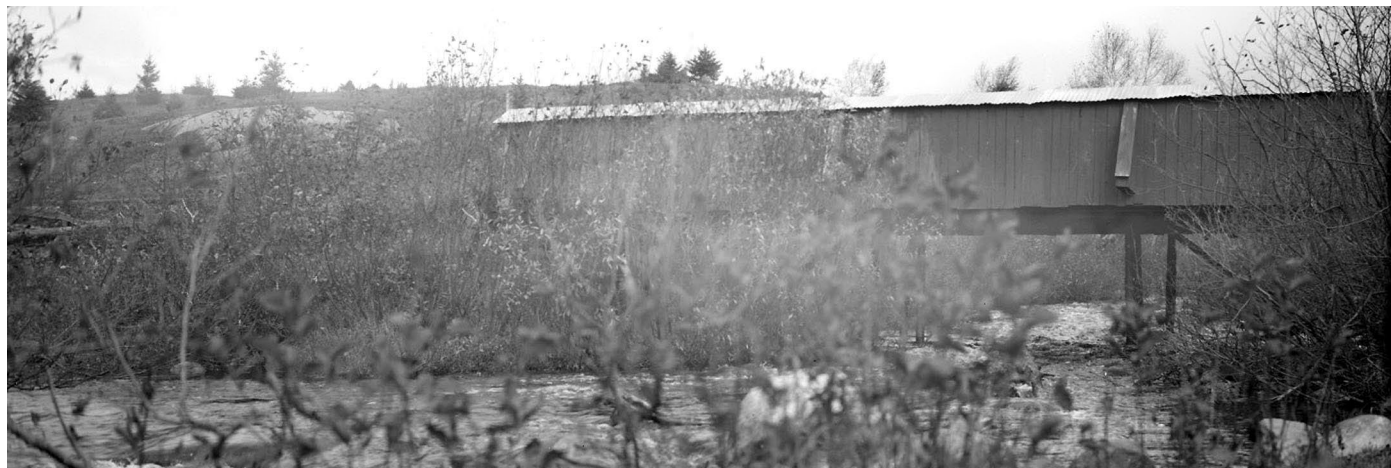
Pont couvert qui enjambe le ruisseau Raphaël dans le canton de Bégin, en 1948. Source : Jean COURNOYER. © BAnQ Québec, cote E6,S7,SS1,P66795
