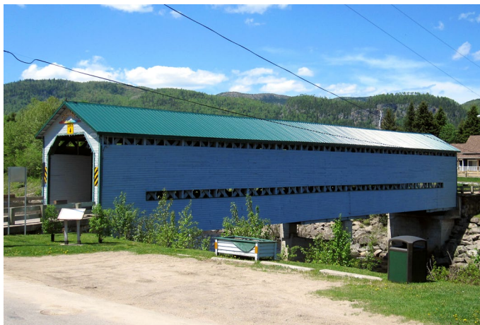
Le pont couvert du Faubourg surplombe la rivière Saint-Jean.
