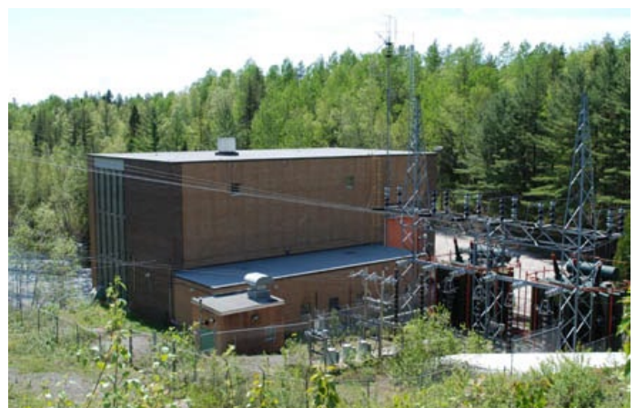
Centrale hydroélectrique Jim-Gray aménagée en 1953. Saint-David-de-Falardeau.
