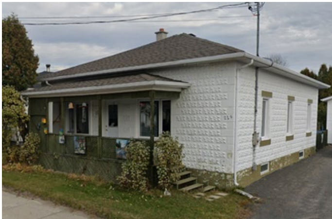
Maison vernaculaire américaine à toit à quatre versants revêtue de blocs de béton. 215, rue Simard, Saint-Ambroise.
