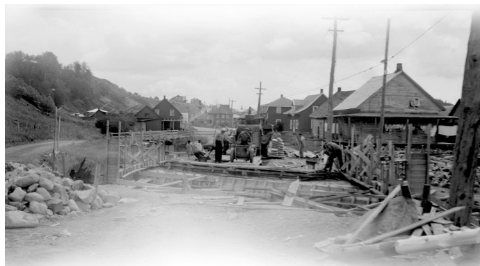
Coulage des fondations en béton du pont au-dessus de la rivière aux Foins, à Saint-Fulgence en 1948. Des résidences qui bordent le chemin de la Mer sont visibles en arrière-plan. Source : J-Augustin FOURNIER. © BAnQ Québec, cote E6,S7,SS1,P65158
