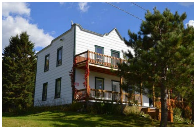
Maison Boomtown munie d'un parapet ainsi que d'une galerie et d'un balcon superposés. 489, rue de la Descente-des-Femmes. Sainte-Rose-du-Nord.
