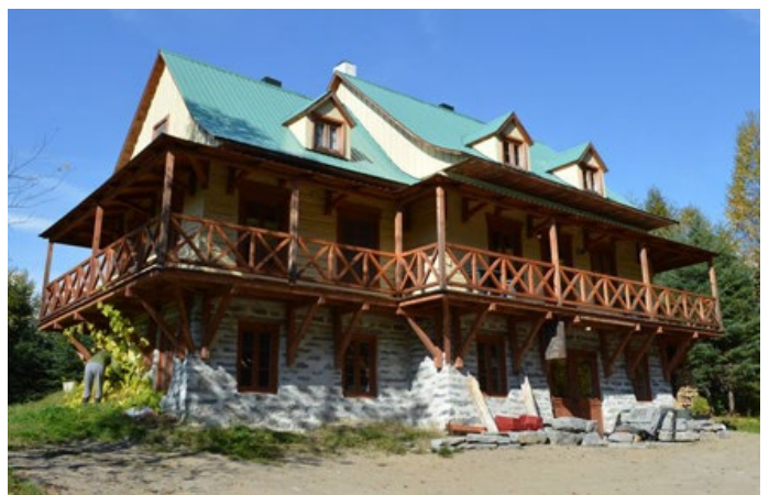
Maison québécoise d'influence néoclassique avec cuisine d'été et fondation en pierre surélevée. 55, rue Dumas, Petit-Saguenay.
