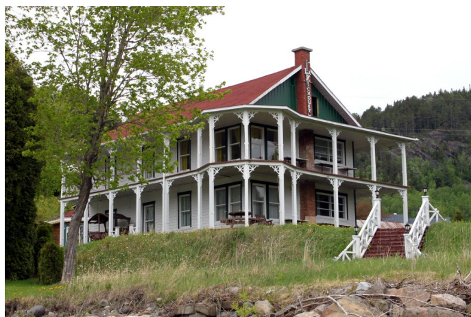
Maison située au 125, rue des Artisans.
