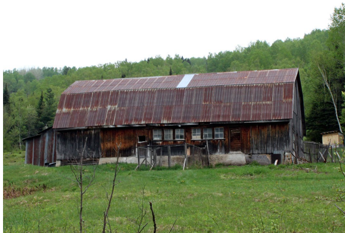
Grange-étable sur le chemin du Tableau.
