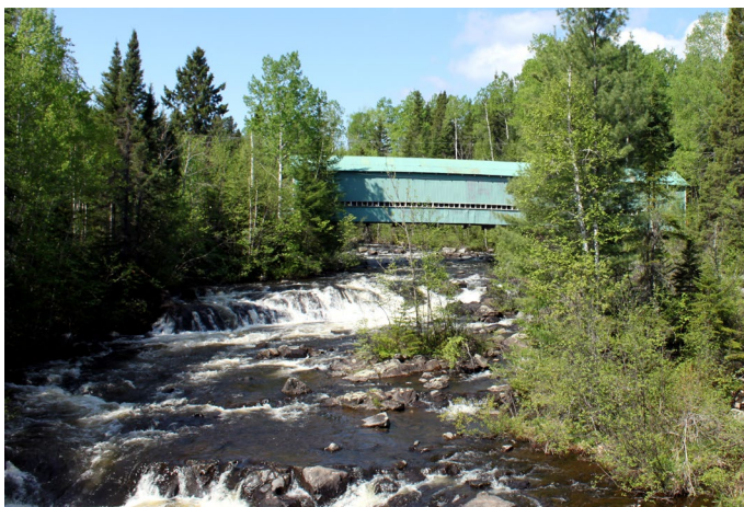
Vue du pont couvert du Lac-Ha! Ha! depuis le pont de la route 381.
