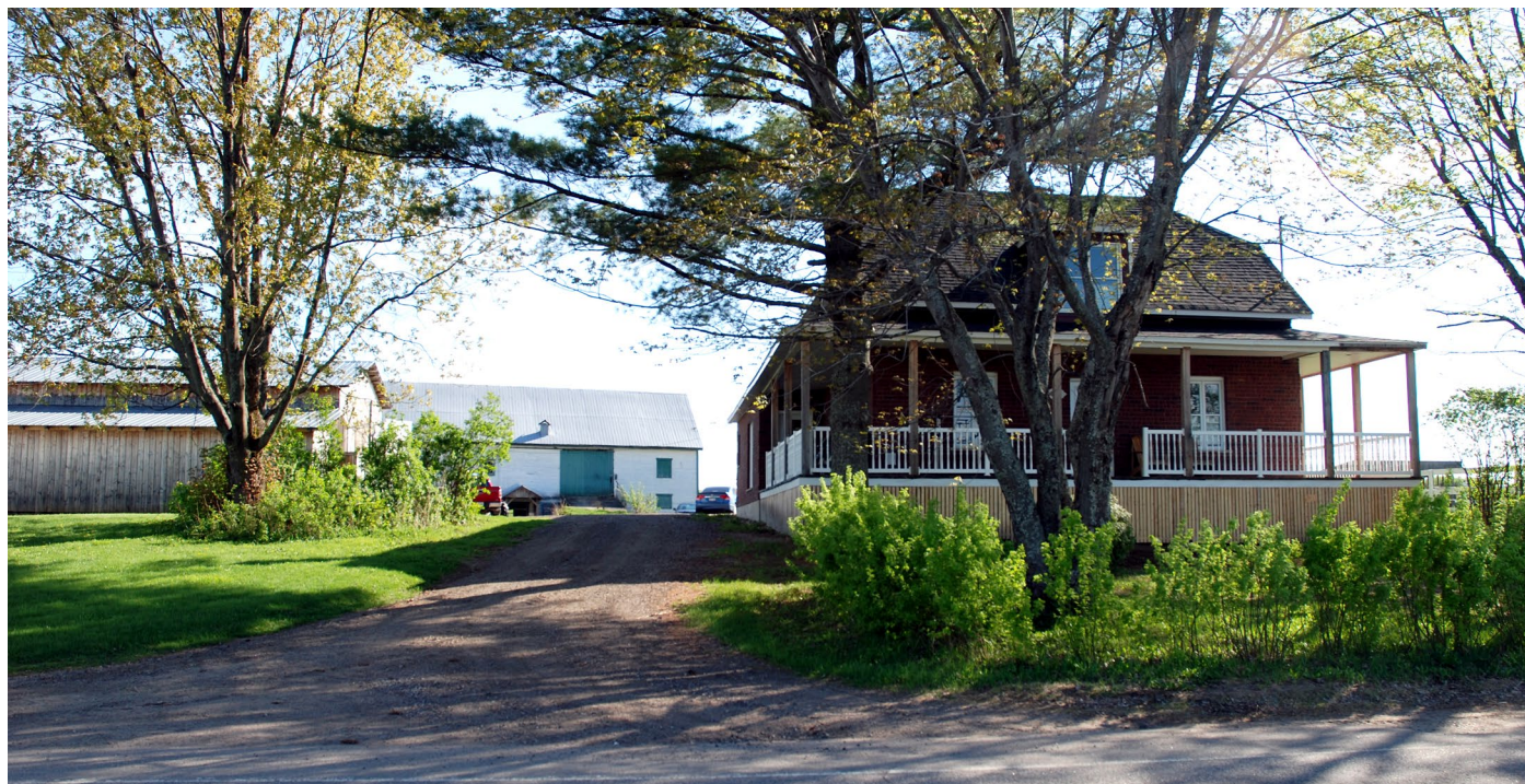
Ensemble de ferme situé au 427, rue Principale.
