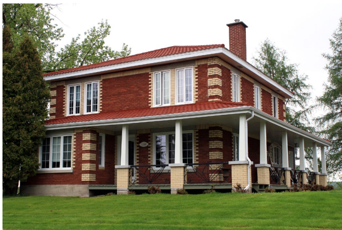
Grande maison en brique située au 1130, rue de l'Hôtel-de-Ville.
