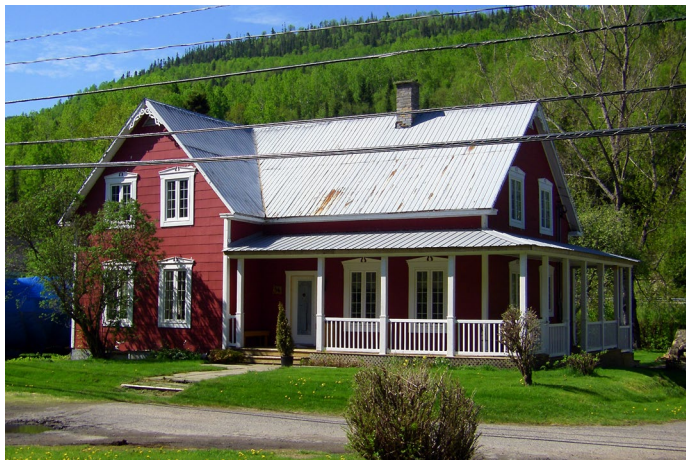
Maison située au 56, rue Dumas.
