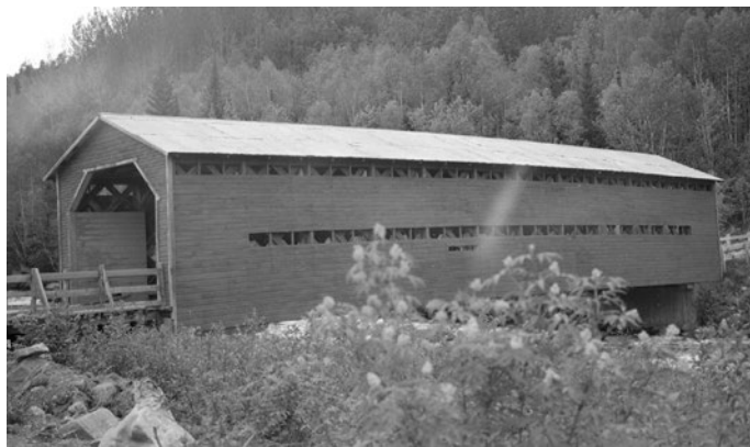
Le pont couvert du Faubourg est construit en 1929. Source : Jean COURNOYER, vers 1948. © BANQ Québec, cote E6,S7,SS1,P63604
