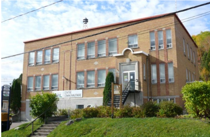
L'ancien couvent des Filles de Sainte-Marie-de-la-Présentation est construit en 1950. 709, rue Gauthier, Larouche.
