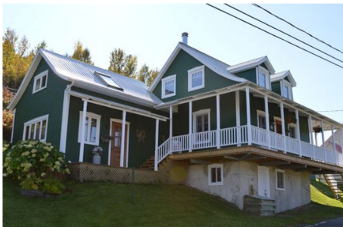
Maison québécoise d'influence néoclassique dotée d'une cuisine d'été. En raison de la pente du terrain, la maison est aussi rehaussée sur de hautes fondations en façade. 10, rue du Faubourg, L'Anse-Saint-Jean.
